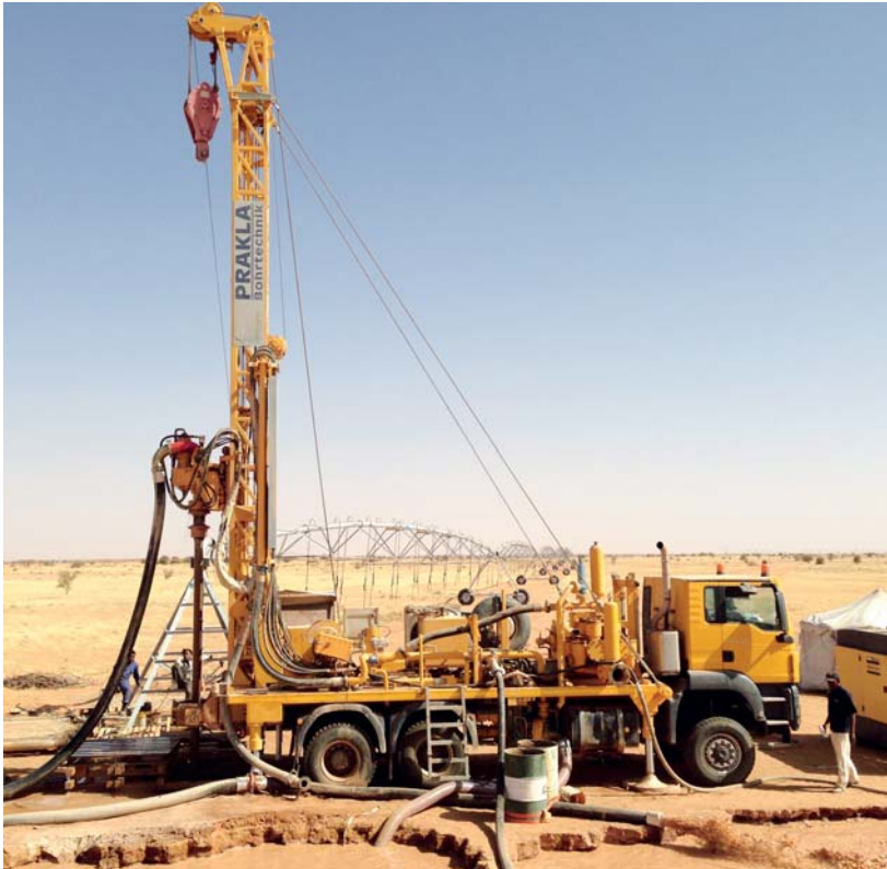
RB 50 бурение скважины для орошения RB 50 drilling irrigation wells
